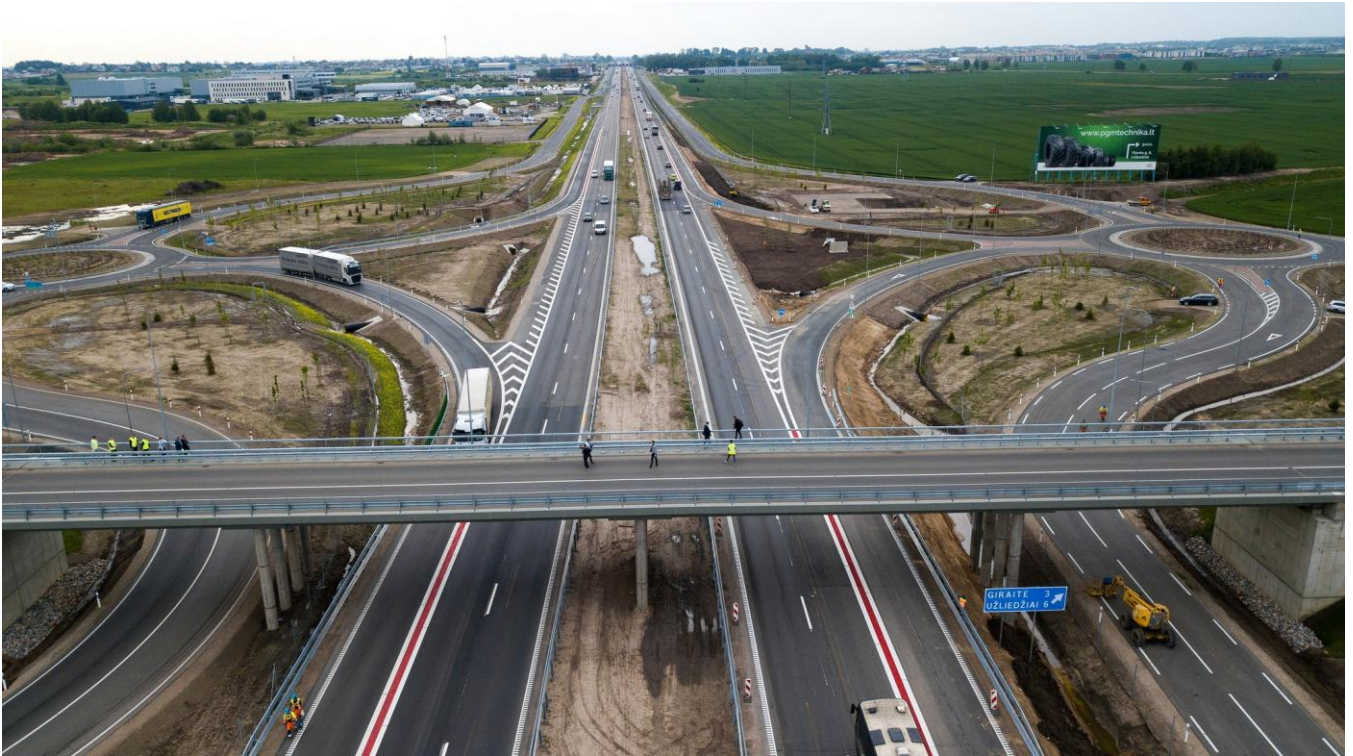
55 pav. Valstybinės reikšmės magistraliniame kelyje Nr. A1 Vilnius–Klaipėda esanti kelių lygių sankryža - Giraitės viadukas.
