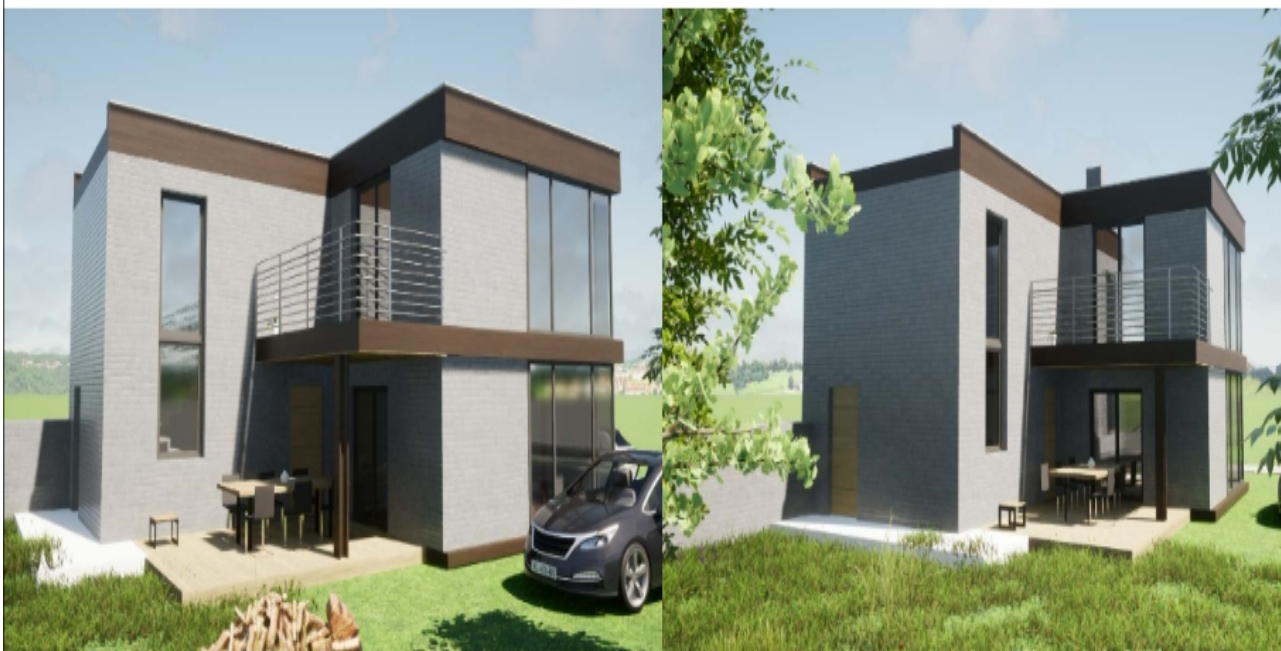
Statinys po rekonstrukcijos
